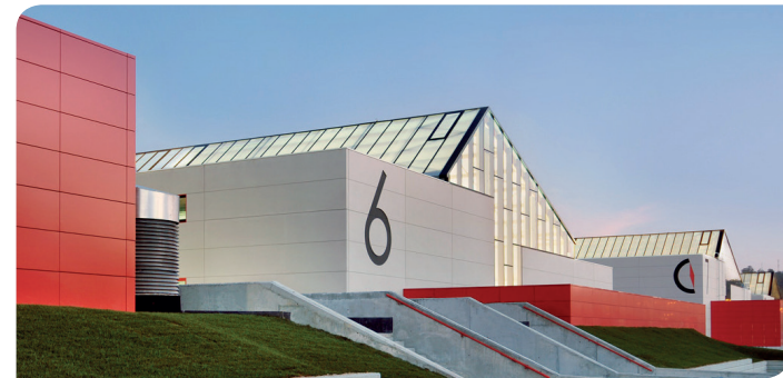
Naves Industriales Zona Franca (Vigo)
